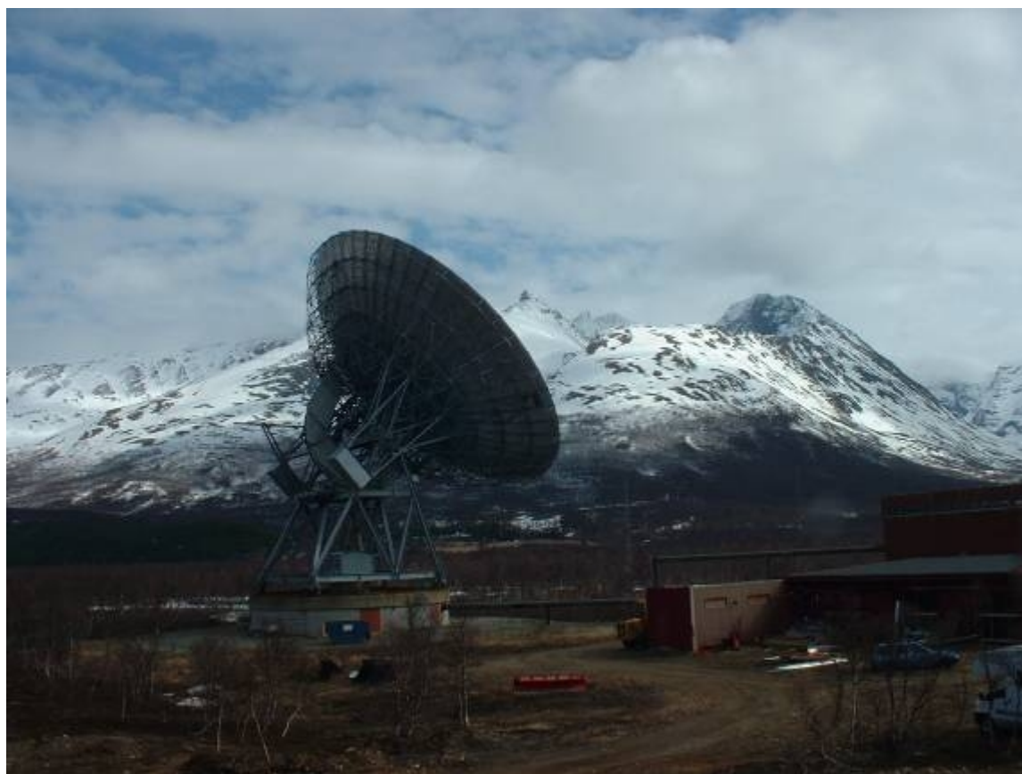
Радар около Тромсо, Норвегия. Частоты 224, 500 и 928,4 МГц. Мощность в импульсе около 2 МВт.
